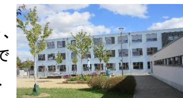
中庭から見た、新築の校舎
